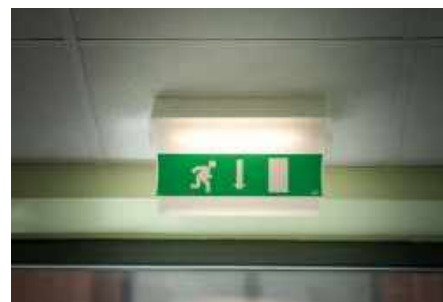
Medición de luces de emergencia y evacuación
